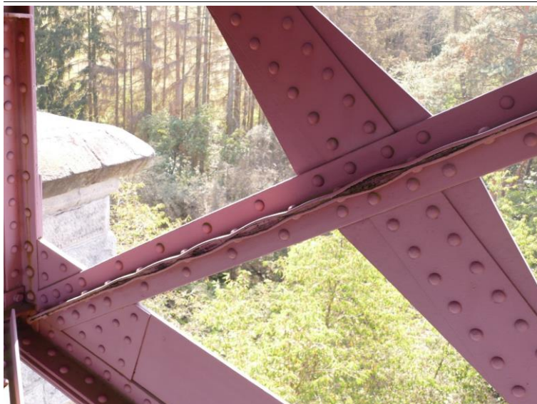
Konstrukce K 03 – štěrbinová koroze mezi úhelníky diagonály hlavního nosníku (příhrada č. 10 vpravo)
