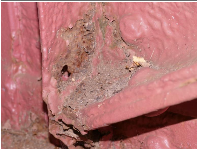
Konstrukce K 01 – korozní oslabení prvků vlevo na začátku při dolním pásu hlavního nosníku, prokorodování svislého ztužení nad ložiskem
