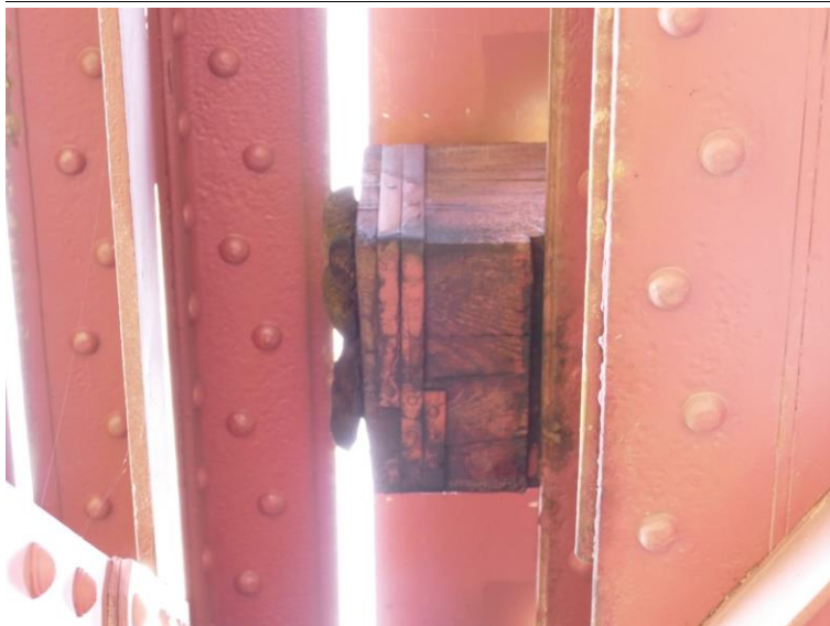
Konstrukce K 03 – mostnice č. 18 napadena dřevokaznou houbou
