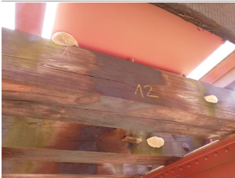
Konstrukce K 01 – mostnice č. 12 a 13 napadena dřevokaznou houbou
