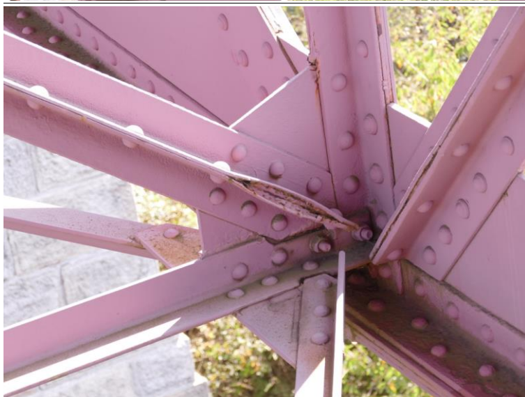
Konstrukce K 03 – štěrbinová koroze mezi úhelníky příčného ztužení
