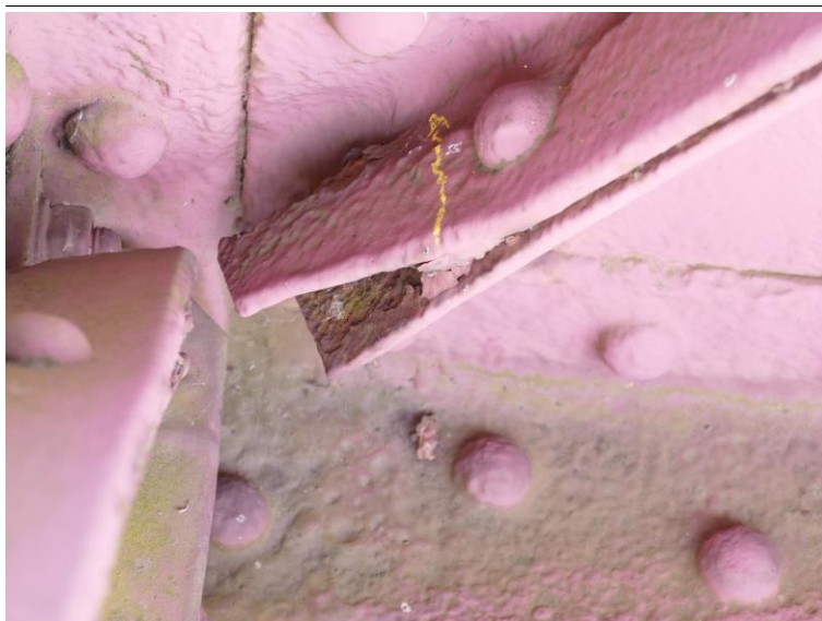
Konstrukce K 02 – tržený úhelník diagonály hlavního nosníku v 6. příhradě vlivem štěrbinové koroze
